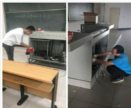
为保障下学期教学设备能够正常运行、保障教学质量，开学前对175间多媒体教室进行维修保养，主要对多媒体机柜进行全面清理工作，清灰擦拭，打泡沫胶；计算机更新软件，打补丁，杀毒；调试所有教室的网络，安装驱动；维修功放，更换投影机灯泡，维修中控，更换鼠标键盘等。
